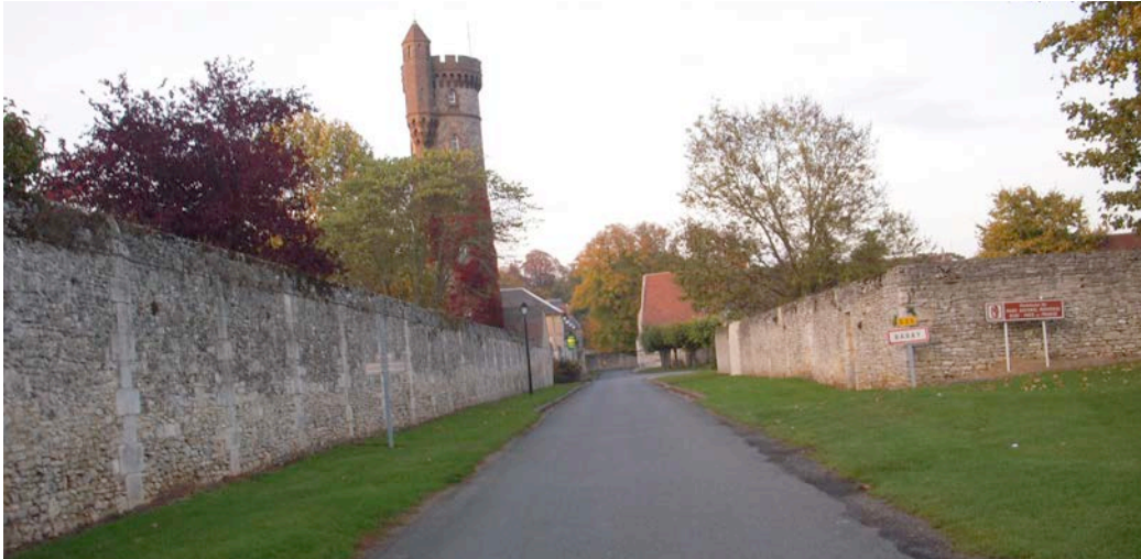
Tour et murs remarquables en entrée de secteur aggloméré ouest.
