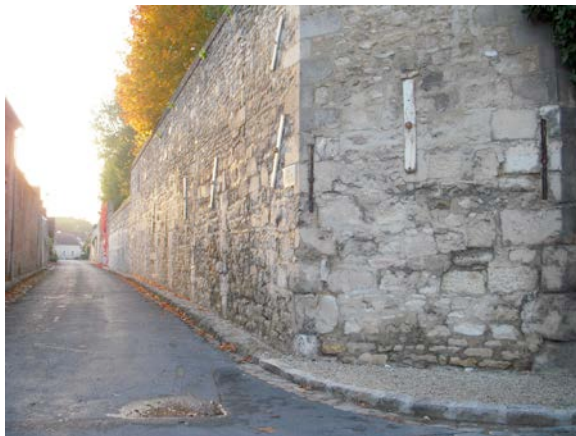
Mur en pierres (côté nord de la rue A. De la Bédoyère).
