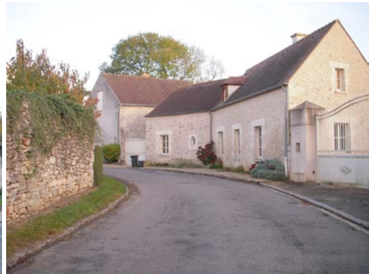
Maison rurale dessinant l'espace public à l'alignement de la rue A. De La Bedoyère.
