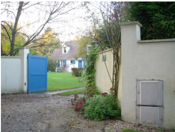
Construction récente Chemin d'Huleux, menuiseries bleues en retrait d'espace public avec mur de clôture.
