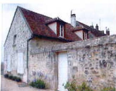
La tuile plate et le moellon calcaire enduit sont les matériaux de construction traditionnels des maisons rurales. Certains pignons sont montés avec une mise en œuvre proche de celle de la pierre sèche. Les murs sont sobres, dépourvus de modénature. Ils comportent rarement une corniche. Un enduit bâtard taloché peut protéger la base du mur.
