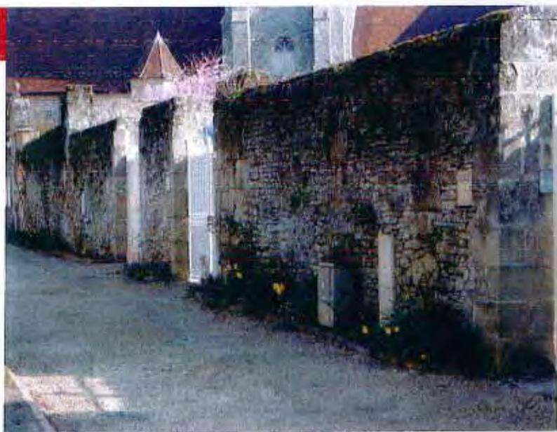
Ces murs sont très ouvragés : tête de mur réalisée par un chaperon convexe de moellons ou une dalle de pierre en saillie pour rejeter les eaux de pluie. Lorsque les murs présentent une certaine longueur, des jambes harpées et des chaînages aux angles les consolident.
