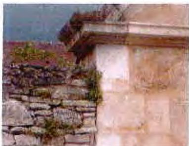
Les enduits sont appliqués totalement (enduit couvrant au mortier de chaux grasse). Parfois ces enduits sont ocrés. Quelques têtes de moellon restent visibles sur certains murs.
