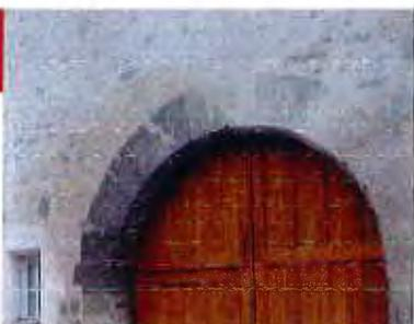
Sur les murs de moellon, harpes et chaînages d'angle en pierre de taille viennent renforcer la maçonnerie.
