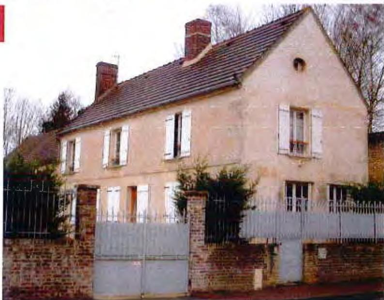
Les façades sur rue sont généralement ordonnancées : alignement horizontal des linteaux et des appuis, superposition et hiérarchisation des fenêtres. Par leurs couleurs, volets et portes habillent la façade en harmonie avec le ton des pierres et de l'enduit.
