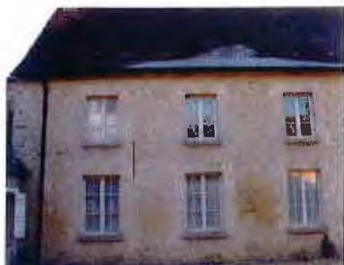
Les chaînages et encadrements de baies sont réalisés en pierre de taille. On observe des linteaux de bois recouverts d'enduit ou de peinture à l'origine. Les appuis de fenêtres sont souvent formés par des pierres plates.
