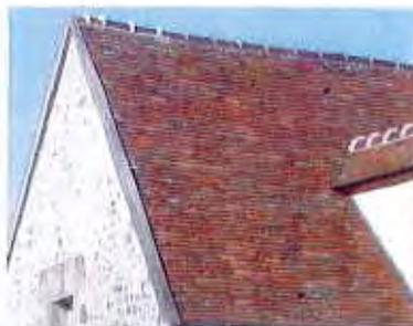
Les couvertures traditionnelles de ce village sont en tuiles plates de petit moule (60 à 80 au m<sup>2</sup> environ), le faitage est scellé au mortier clair avec des tuiles demi-rondes (faitage à crêtes et embarrures). Les rives sont souvent protégées par un solin de plâtre appelé la ruellée. Celle-ci empêche la pluie de s'infiltrer sous la toiture.
