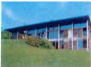
Maison intégrée au site naturel, avec utilisation passive de l'énergie solaire, une isolation renforcée, des doubles vitrages isolants, un jardin d'hiver, une mise en œuvre de matériaux recyclables et des finitions saines, un choix d'essences de bois naturellement durables, l'épuration des eaux usées et des eaux vannes par des lits à macrophytes
