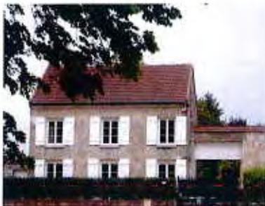
La construction forme un parallélepède rectangle de dimensions variables surmonté d'un toit à deux pans dont la pente est à 45°. La toiture généralement est encadrée par des souches de cheminées établies dans le prolongement des pignons.
