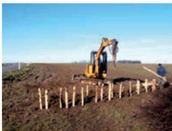
Battage des pieux
